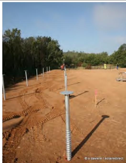
PHOTOGRAPHIE 1 : ANCRAGE AU SOL DES PANNEAUX - VINON SUR VERDON
