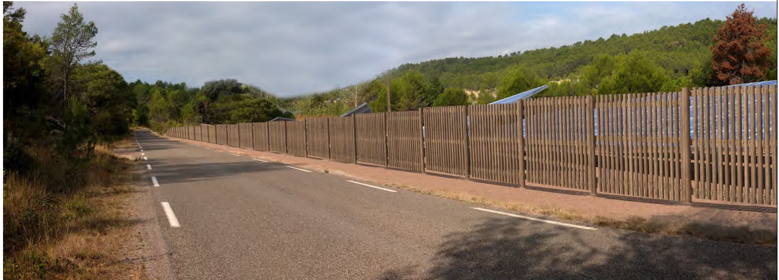
FIGURE 34 : INFOGRAPHIE – VUE DEPUIS LA DEPARTEMENTALE (ENTRE LES POINTS DE VUE N°3 ET N°4 SUR LA CARTE)
