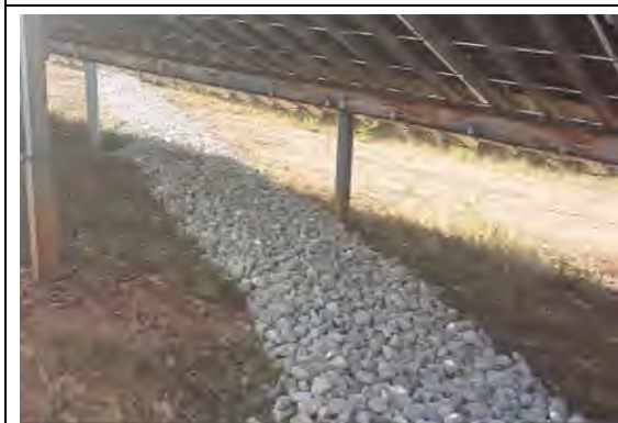
PHOTOGRAPHIE 6 : EXEMPLE DE MICROBARRAGE EN ENROCHEMENT
