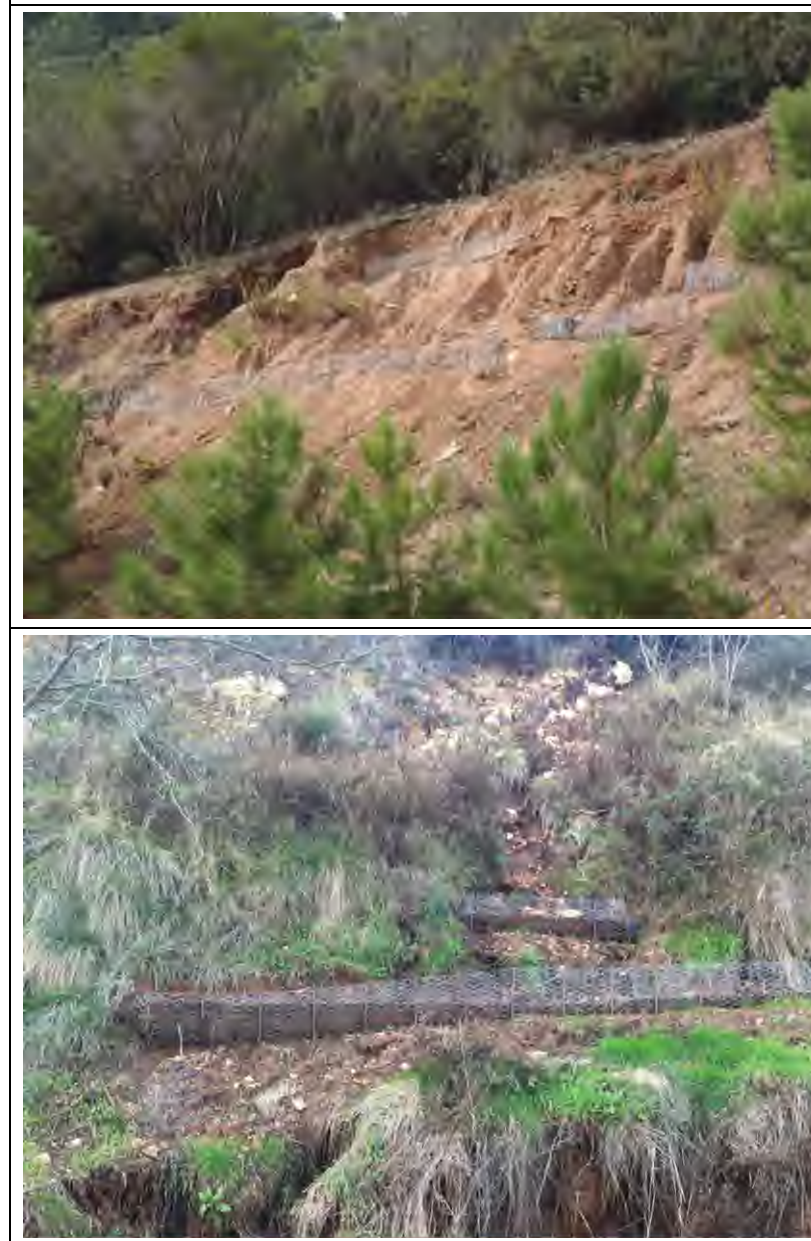
PHOTOGRAPHIE 7 : EXEMPLE DE MISE EN PLACE DE DIGUETTES PERMEABLES
