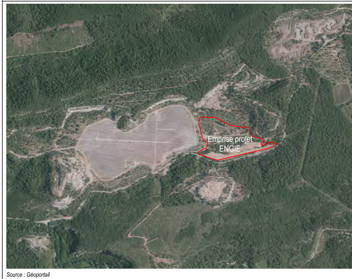
FIGURE 42 : LOCALISATION DE LA CENTRALE SOLAIRE LIMITROPHE
